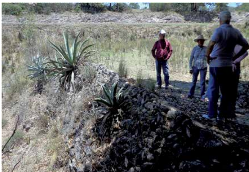
Figura D.1.3. Talud de roca en terraza de valle antigua, actualmente abandonada. Yanhuítlán, Mixteca Alta, Oaxaca, México. Fotografía de Bocco, G. Véase Capítulo D.1, p. 349.
